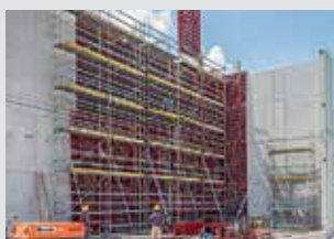
Građevinske radne skele
