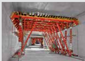
Oplaste za tunele
