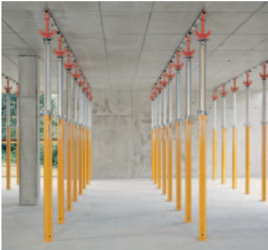
MULTIPROP 350 i Skydeck stropna oplata u demontiranom stanju. Samo 0,29 podupirača/m 2 stropne površine do 40 cm debljine stropa.
