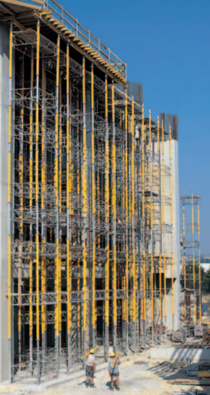
20 m visoki MULTIPROP toranj pri postavi skele konzolne stropne ploče
