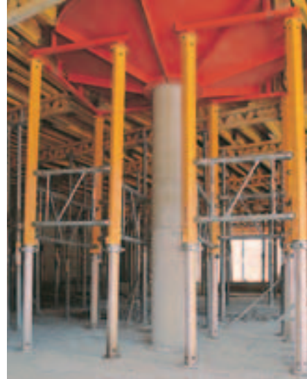
20 m visoki MULTIPROP toranj pri postavi skele konzolne stropne ploče
