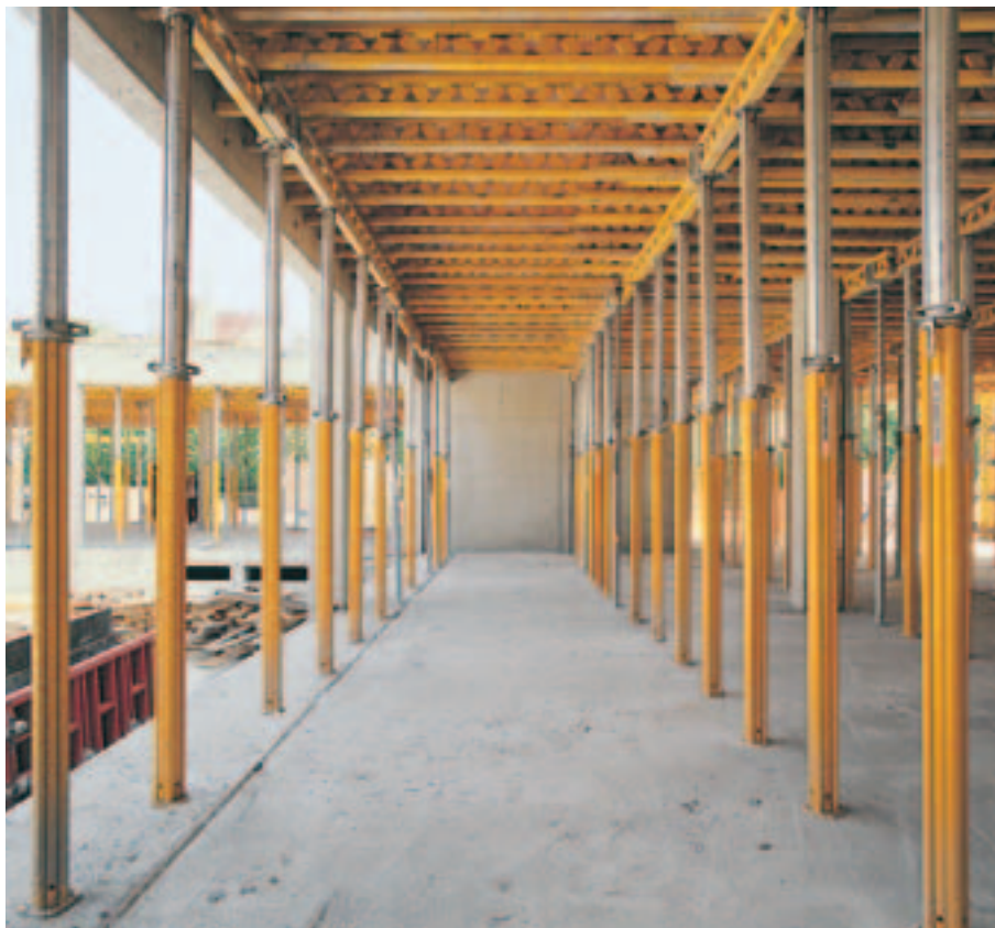
MULTIPROP 350 zajedno sa stropnom oplatom MULTIFLEX.
