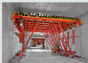
Oplaste za tunele
