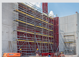
Građevinske radne skele
