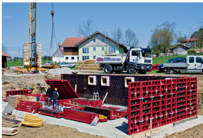
MX sidro kojim se rukuje jednostrano čini MAXIMO izrazito ekonomičnim. Podrum obiteljske kuće Buchenberg/Vorderburg
