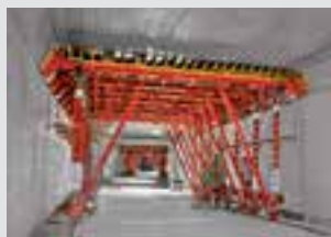
Oplaste za tunele
