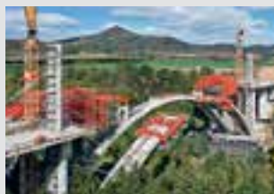
Oplaste za mostove
