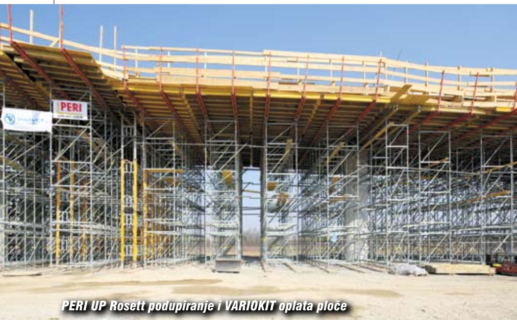
Postavljena skela ispod krivine prilazne rampe
