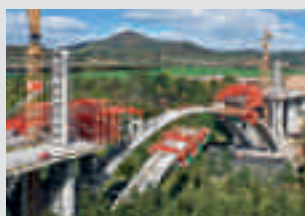
Oplaste za mostove
