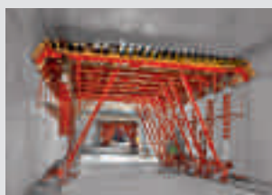
Oplaste za tunele
