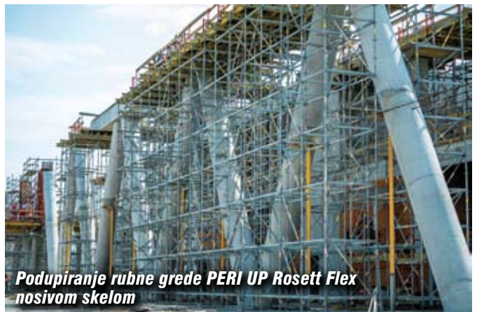
Stropni stolovi od GT 24 nosača na PERI UP Rosett tornjevima
