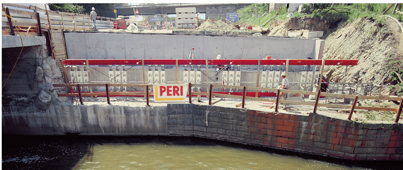
Podupirač za teška opterećenja HD 200 ekonomično se može primjenjivati i pri malim visinama.
