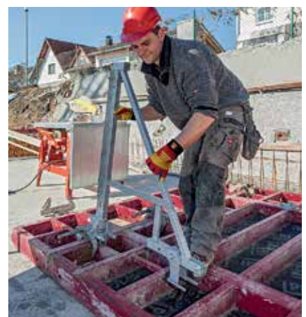
Radni podesti montiraju se na elementu odgovarajuće širine i ostaju na oplati i kod privremenog skladištenja.
