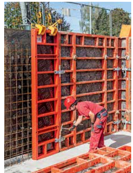
Višenamjenski elementi širine 72 cm primjenjivi su i za vanjske kutove i u ravnom zidu.
