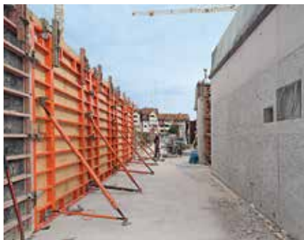
TRIO Struktur varijanta je pouzdane okvirne oplata, primjenjiv je sa svim TRIO priborom.
