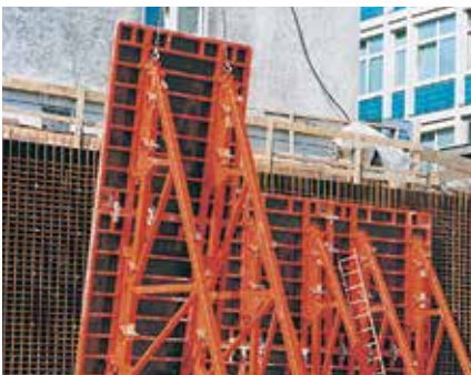
Spoj mehaničkim silama omogućuje premještanje kompletne jedinice.
