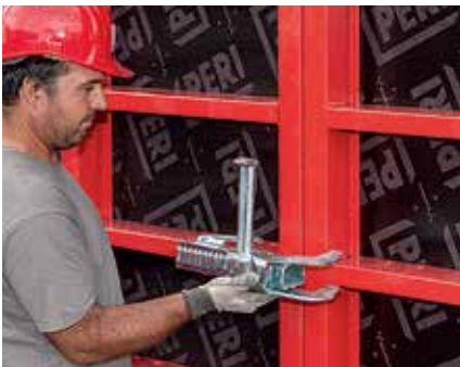
Spojnicom BFD može se rukovati samo jednom rukom.
