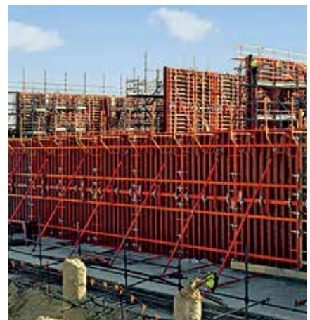
TRIO je moguće nadograđivati do 5,40 m visine u rasteru od 30 cm. Kod većih visina dodatno se primjenjuje profil za izjednačavanje.
