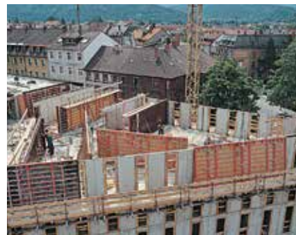
TRIO Struktur može se kombinirati s TRIO standardnim elementima. To je prednost jer se posebne površine često zahtijevaju samo na jednoj strani.
