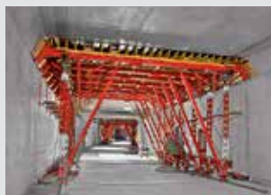
Oplaste za tunele
