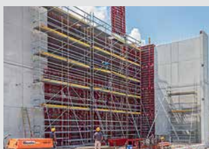
Građevinske radne skele
