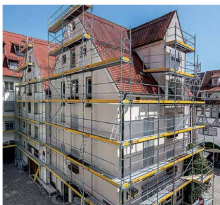
Sanacija kuće za više obitelji, Ulm, Njemačka
