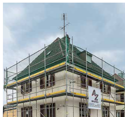
Obnova kuće, Landau, Njemačka
