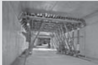
Oplaste za tunele
