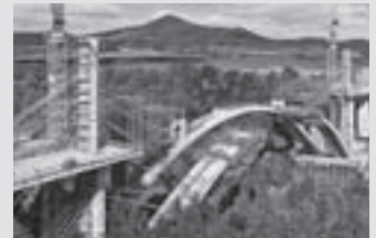
Oplaste za mostove
