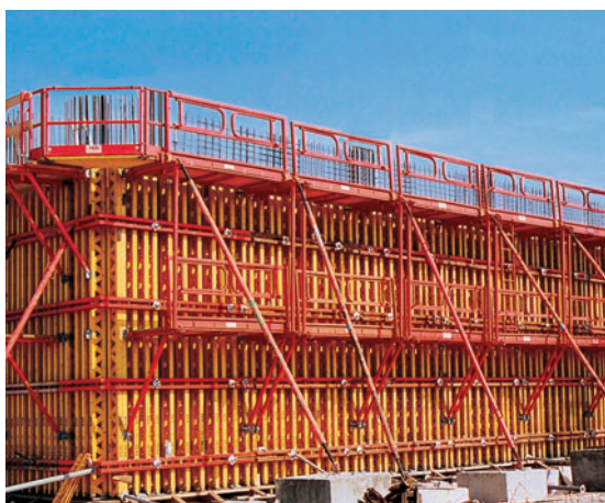
6,00 m visoki VARIO GT 24 standardni elementi s podeštima pri gradnji sajamskog centra.
