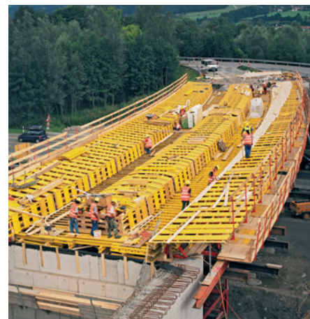
Ekonomično specijalno rješenje: oplata mosta s nosačem GT 24.
