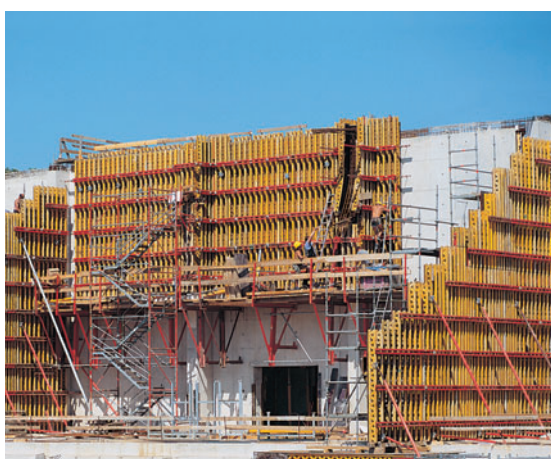
Nosač GT 24 omogućuje optimalnu prilagodbu geometriji građevine.
