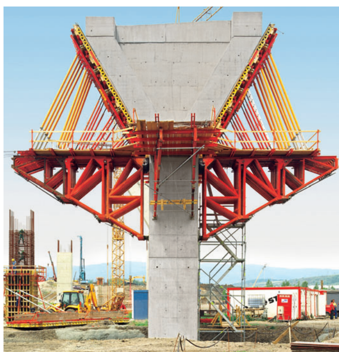
Gornja konstrukcija mosta, Kiefersfelden, Njemačka Skele s nosačima GT 24 presjeka pločastih greda u cijelosti su se sastojale od PERI serijskih dijelova.
