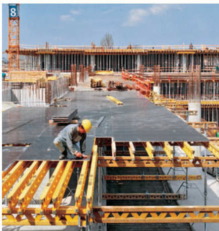
GT 24 kao nosač oplata kod MULTIFLEX oplata stropa.
