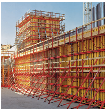
Bez obzira na visinu, s GT 24 sve je moguće: nosači duljine do 17,80 m bez spoja.
