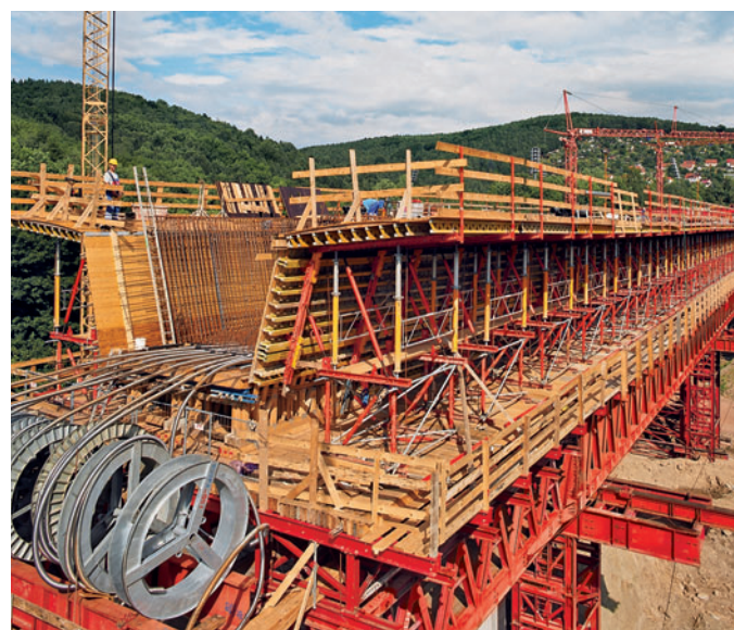
Most Lößnitztal, Aue, Njemačka Specijalna oplata s GT 24 i PERI sistemskim dijelovima iz najma.
