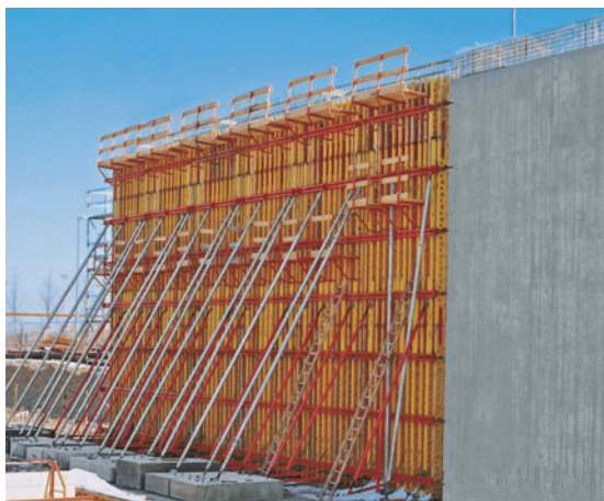
Dvostruko nadograđeni VARIO elementi visine 10,20 m pri gradnji podzemne garaže.
