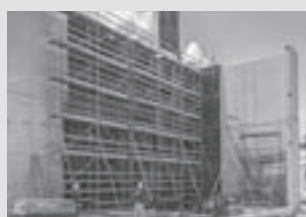
Građevinske radne skele
