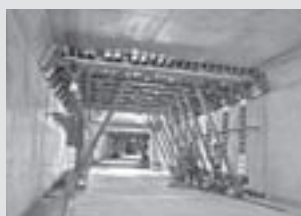
Oplaste za tunele
