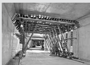
Oplaste za tunele
