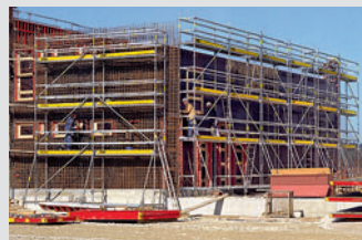
Građevinske radne skele
