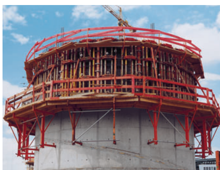
RUNDFLEX elementi na penjačkoj skeli KG 180 kod gradnje rotora parkirne garaže.
