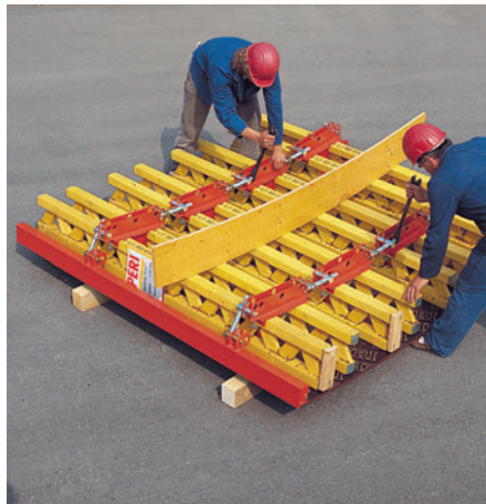
Kontrola zadanih zakrivljenja izvodi se postavljanjem šablona polumjera na nosače oplate.
