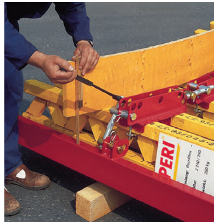
Vretenom 210 za podešavanje rubnog profila rukuje se pomoću kombi ključa za montažu.
