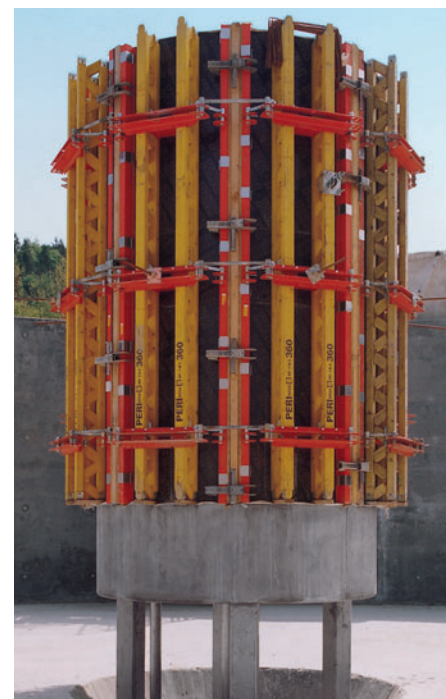
“Kraljevski stolac” uređaja za pročišćavanje, promjera 1,10 m i montiranog elementima A 85, I 72.
