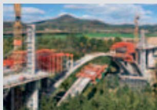
Oplaste za mostove
