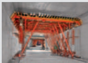
Oplaste za tunele
