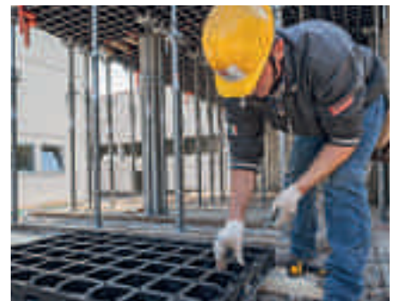
4. Pritezanje nove oplatne ploče vijcima
