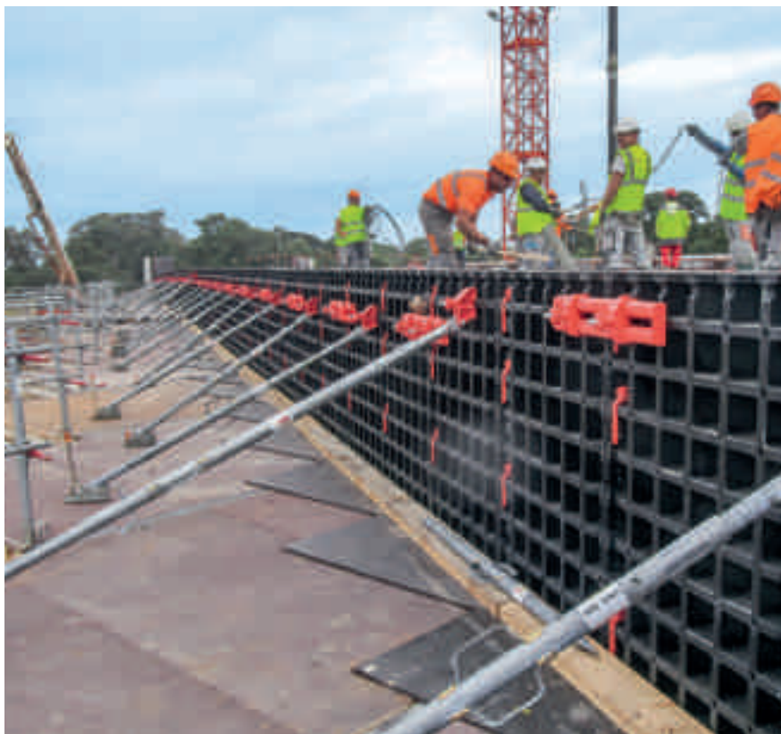
DUO je zahvaljujući malim veličinama panela i jednostavnom rukovanju predodređen za montažu temelja.
