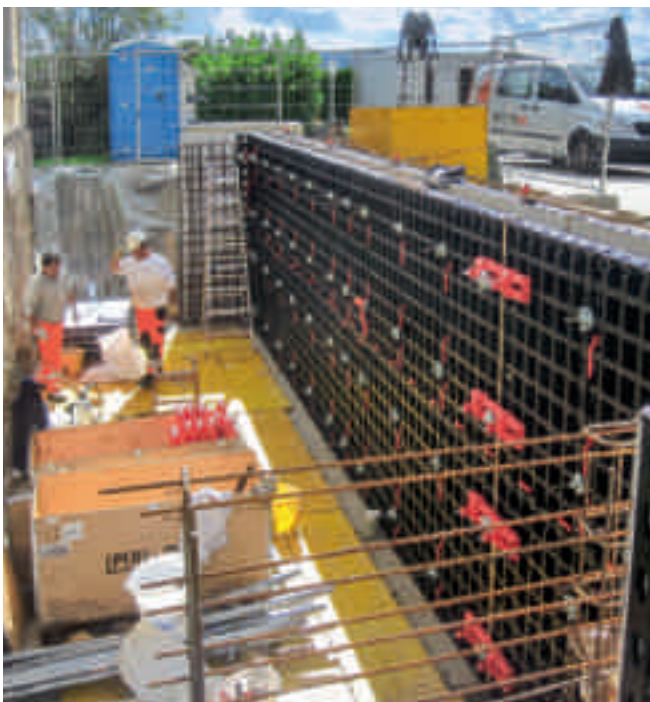
Preinake i montaža bez primjene dizalice - najbolje rješenje s DUO oplatom
