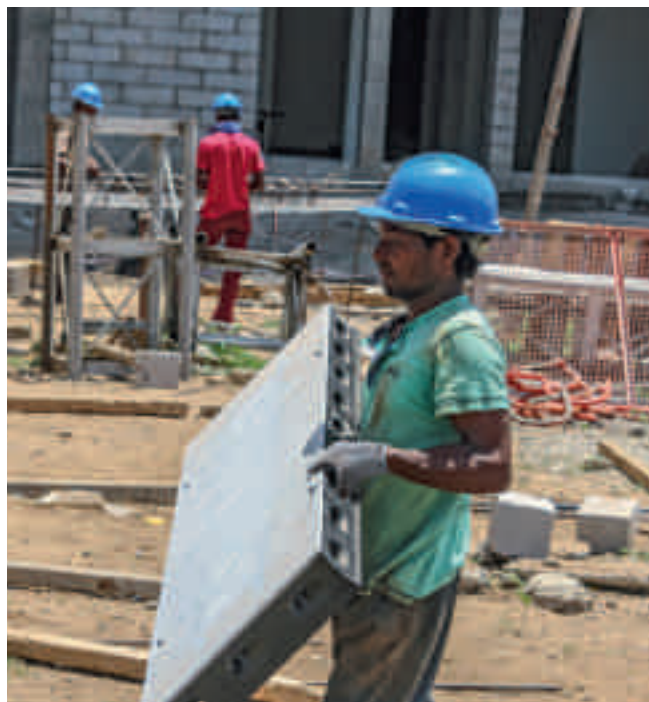
Brza montaža i demontaža u Indiji
