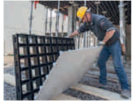
2. Uklanjanje oštećene oplatne ploče
