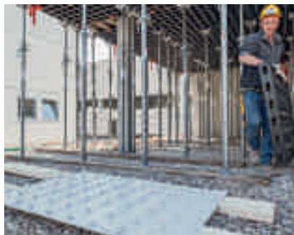
3. Priprema nove oplatne ploče
