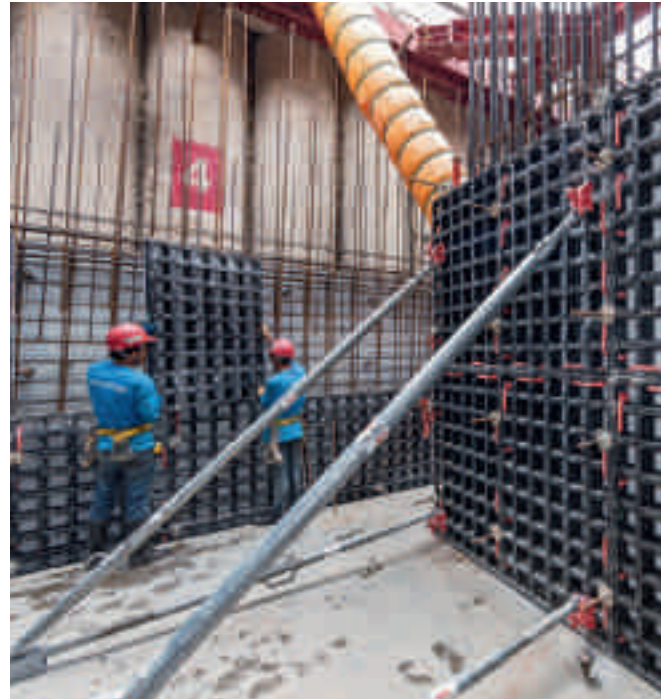
Neznatna težina, elementi oplate malog formata - ove prednosti DUO u potpunosti demonstrira kod zidova suterena
