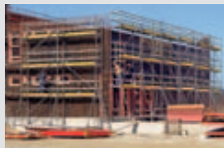
Građevinske radne skele
