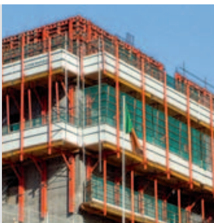
I okvirna oplata TRIO može se koristiti s RCS penjačim sistemom.
