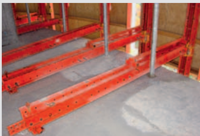
Kako bi se RCS penjajući zaštitni zid vodio u jednoj liniji i na građevinskim objektima sa stalno izmjenjivim istacima na stropnim rubovima, PERI s horizontalno izbočenim penjajućim profilima RCS i odgovarajućim
