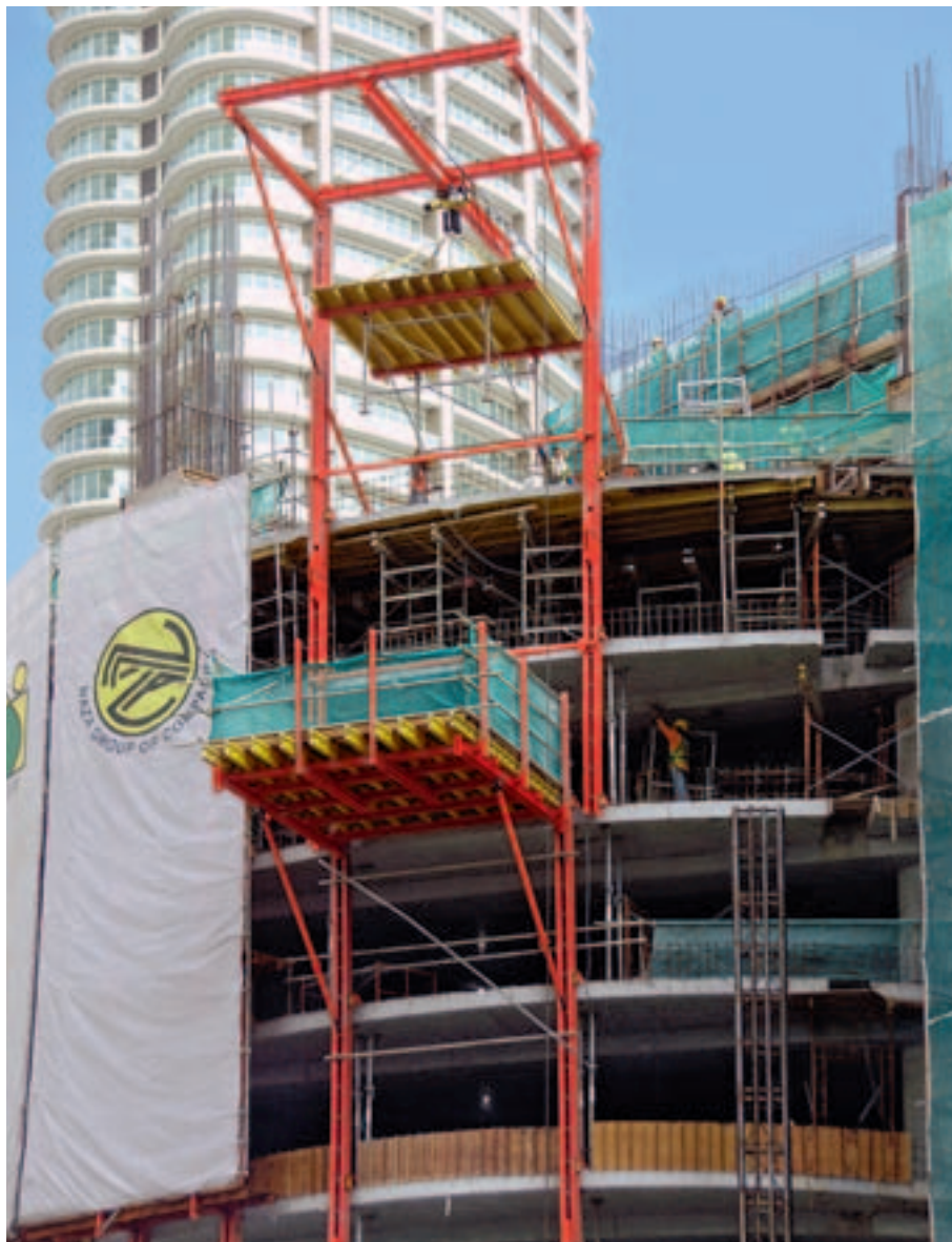
RCS ML lift za materijal prilikom primjene na neboderu u Maleziji.
