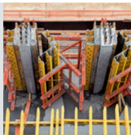
... kao i preklopne oplata za podupiranje na fasadi nebodera.
