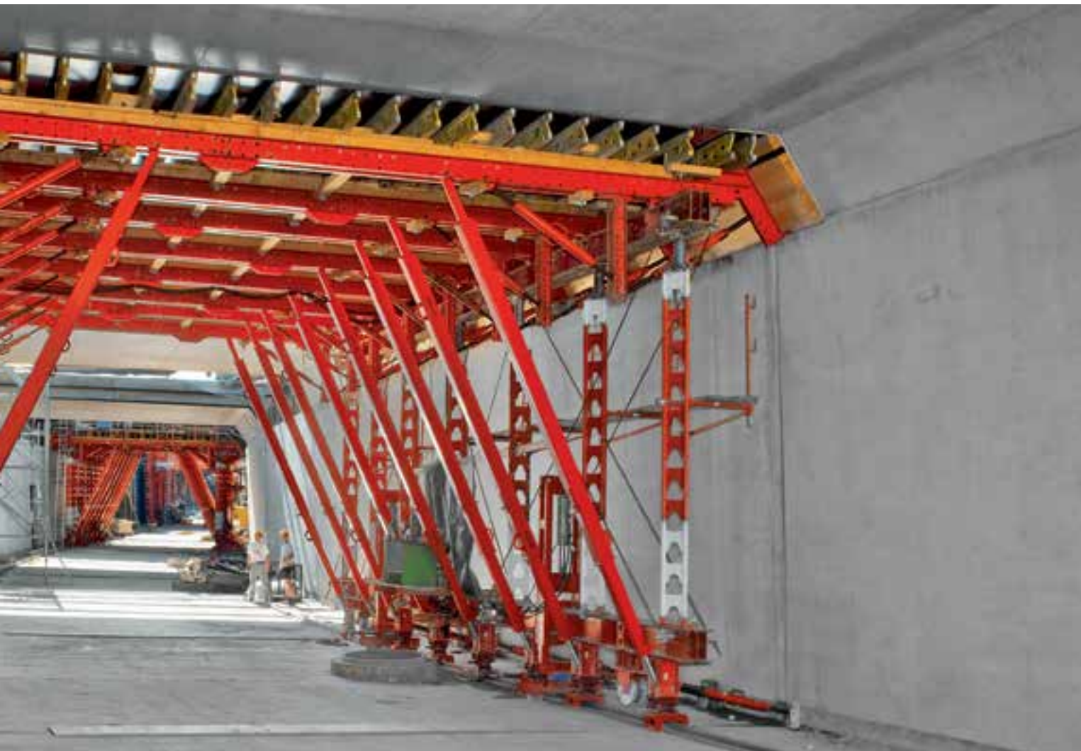
Jasno su vidljiva 2 zasebna takta betoniranja, slijeva zid i zdesna strop. Obje oplate izvedene su kao pomične jedinice.
