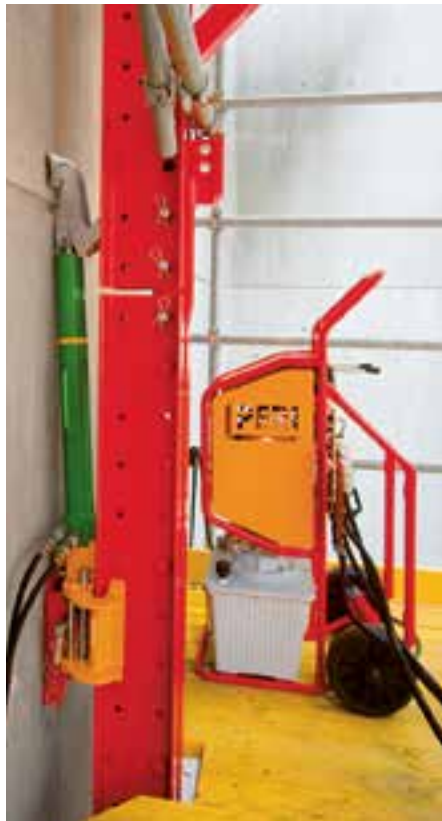
RCS penjajuća šina s hidrauličkim penjajućim mehanizmom.
