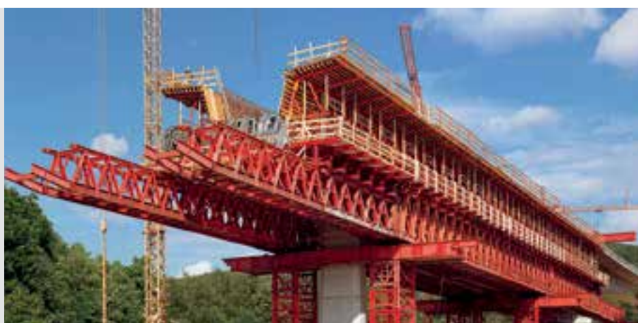
I rasponske konstrukcije za taktno naguravanje s donje strane mogu se nadopunjavati sistemskim oplatama te time ekonomično primjenjivati. Za premještanje se najprije skela i oplata pomiču bočno, zatim u uzdužnom smjeru te onda ponovno poravnavaju.
