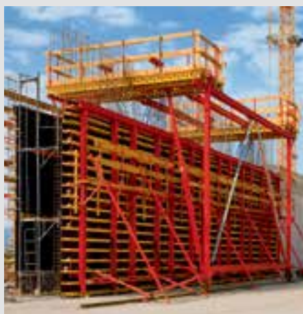
Jasno su vidljiva 2 zasebna takta betoniranja, slijeva zid i zdesna strop. Obje oplate izvedene su kao pomične jedinice.
