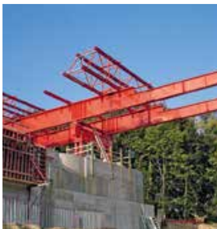
Montaža građevinskih grupa na poziciji iza ležišta pravilo je za prvu montažu. Pritom se mora voditi računa o prolasku zida ležišta.
