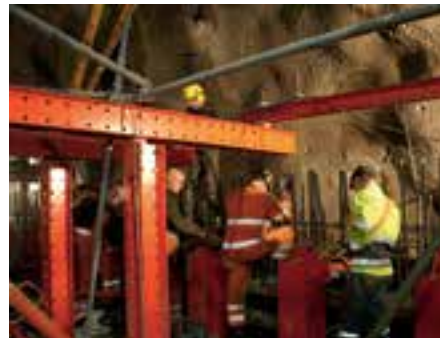
Sistemske komponente kod kolica za montažu i vozni ovjes oplata dopuštaju fleksibilnu primjenu.
