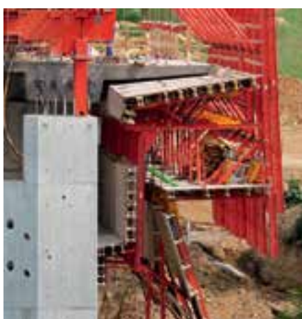
Prolazak stupa bez problema je moguć nakon hidrauličkog spuštanja radnog podesta i oplata tla.
