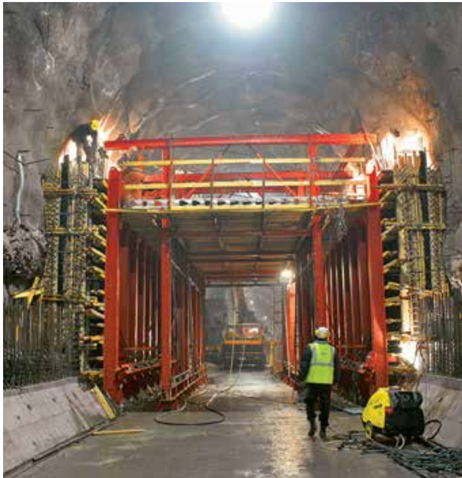
Prvi odsječak s temeljnom pločom i prvom oplatom već je betoniran.
