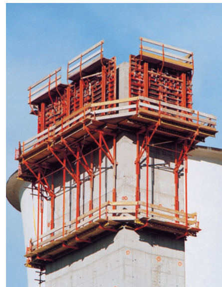
Upravna zgrada CB 240 sa slijednim podestima i TRIO oplatom.
