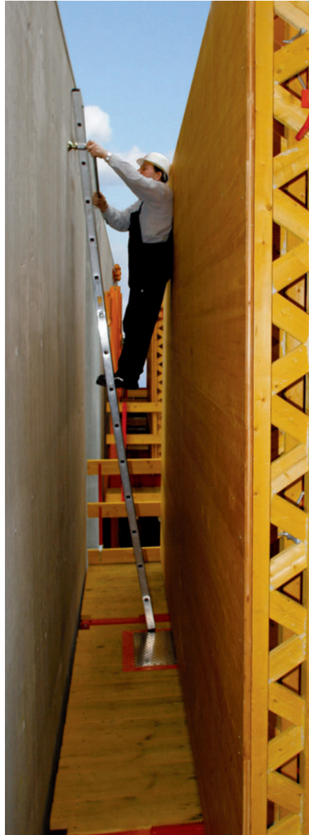
Siguran rad na CB 240 u zaštiti elemenata oplata.
