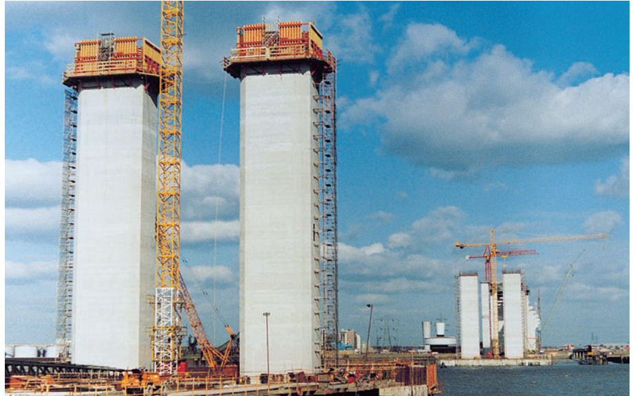
CB 240 s VARIO GT 24 prilikom gradnje upornjaka mosta.
