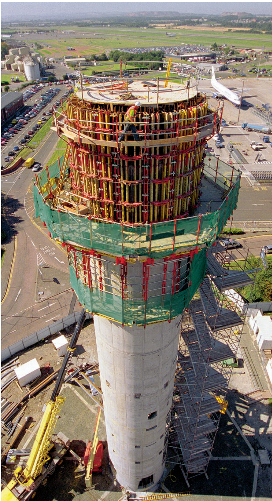
Kontrolni toranj zračne luke 46 m visine, Ø 6,85 m izvana. S RUNDFLEX oplatom i CB 240 konzolama.
