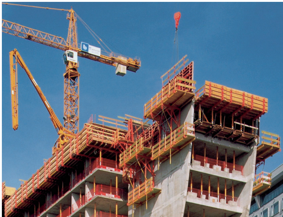
Gradnja hotela CB 240 konzole u kompletu sa slijednim podestom i TRIO oplatom.
