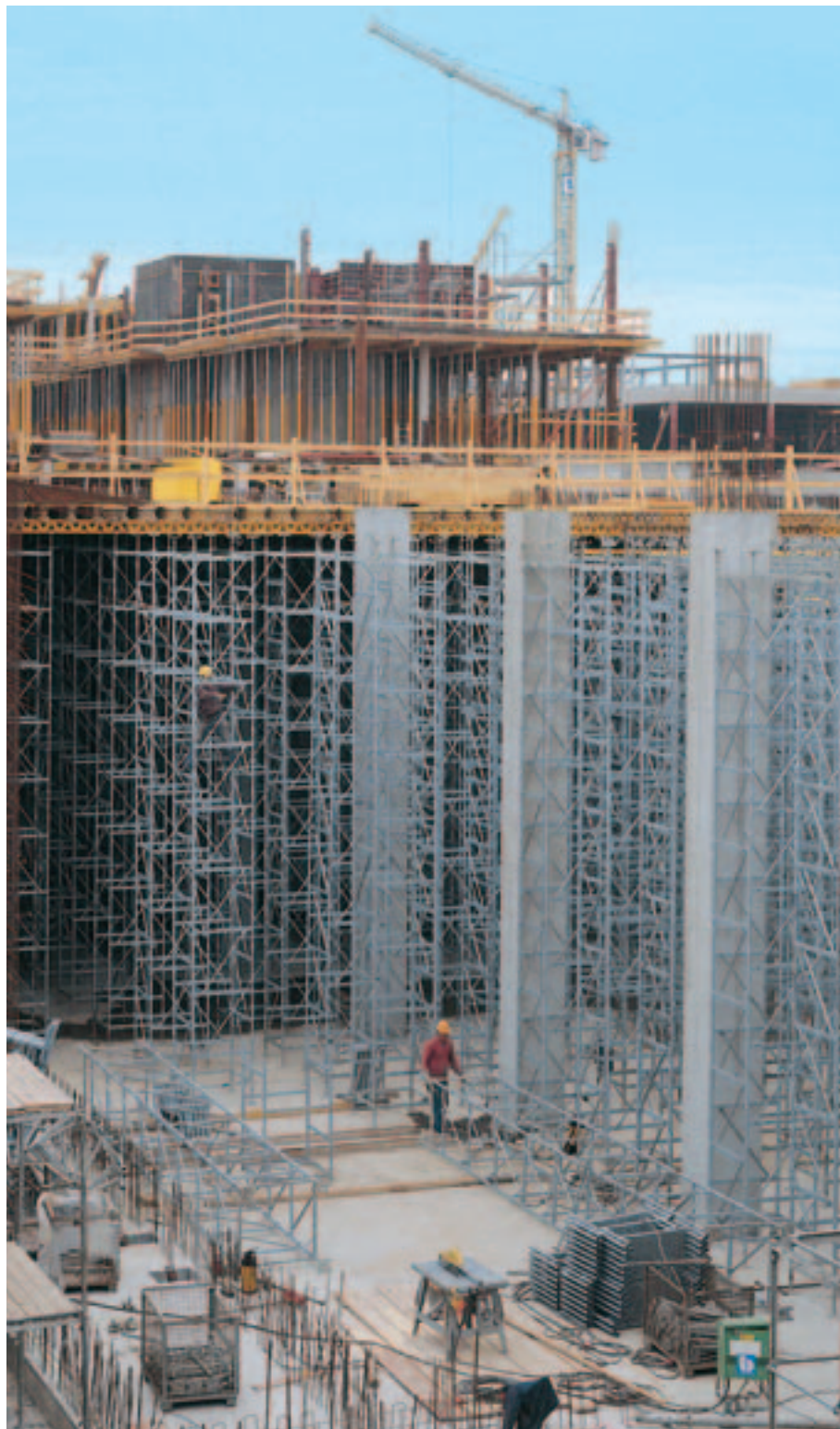
Predmontaža složivog tornja ST 100 moguća je na tlu u ležećem položaju.
