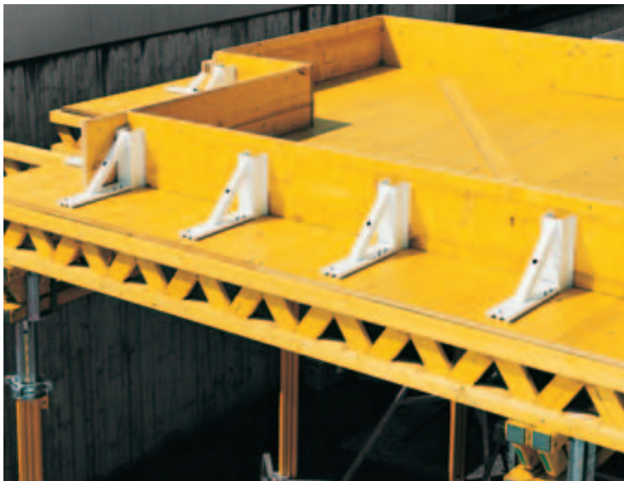
Čeoni kutni element za čeonu montažu stropova do 40 cm debljine.
