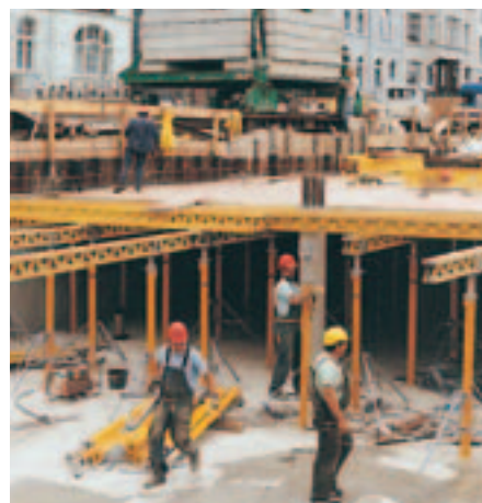
Gradnja podzemne garaže pomoću dvostrukih GT 24 primarnih nosača. MULTIPROP podupirači mogu prenositi velika opterećenja. Rezultat: brza montaža s malim brojem dijelova.
