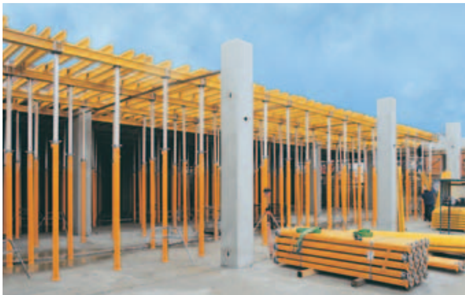
VT 20K kao primarni i poprečni nosač. Lagani MULTIPROP 480 visoke nosivosti kao potpora.
