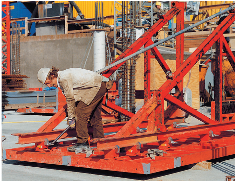
Montaža okvirnog podupirača SB-A, B, C na TRIO elementima u ležećem položaju.
