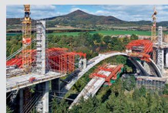
Oplaste za mostove
