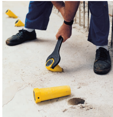
...i lagana demontaža prethodne spojnice nakon betoniranja.
