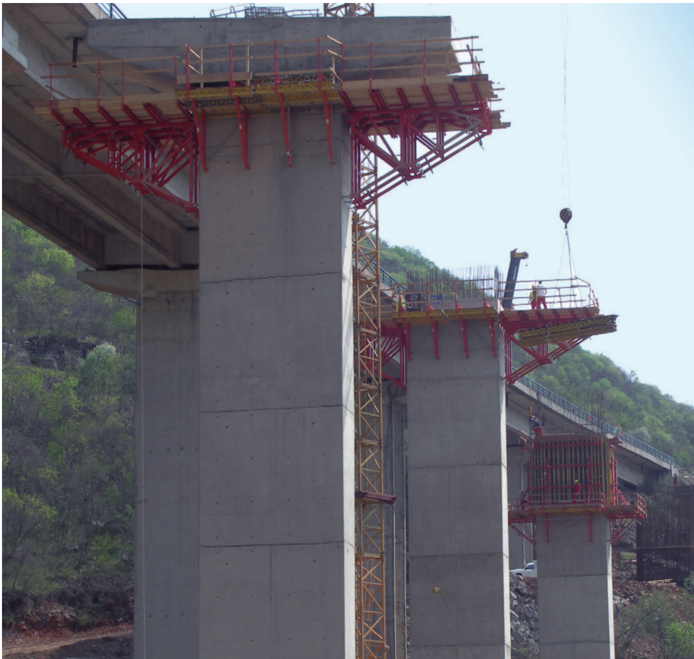
Primjena sistema okvirnog podupirača SB-A, B kao radne konzole i konzole za teška opterećenja.
