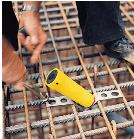
Jednostavno fiksiranje sidrenja na armaturu...
