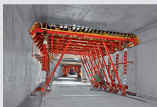
Oplaste za tunele
