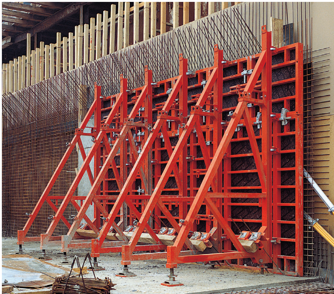
Okvirni podupirač SB-B, C s oplatom TRIO, visina montaže 3,00 m.
