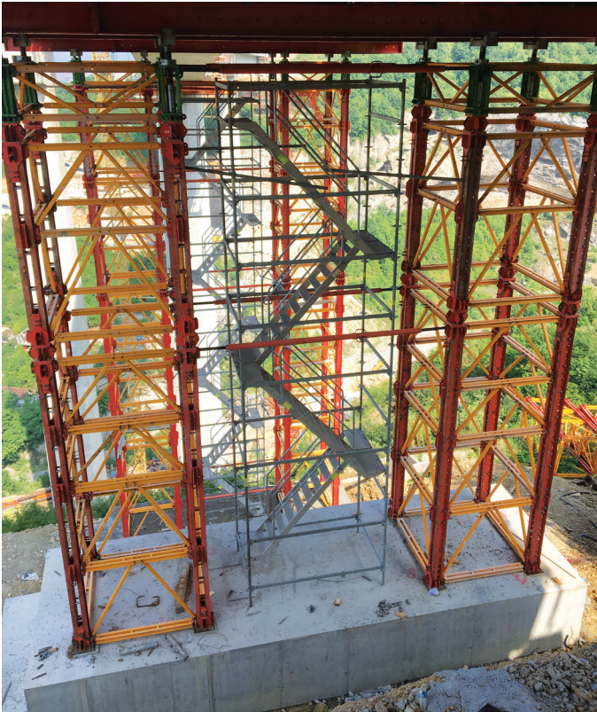
Vijadukt Babina rijeka, Koridor Vc, Zenica (STRABAG d.o.o. Sarajevo) Primjenom HEB profila umjesto VRB rešetke te zahvaljujući dodatna dva VST tornja ostvarena je značajna ušteda troškova materijala.
