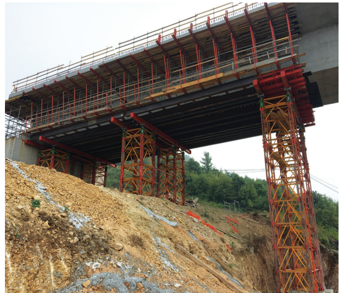
Vijadukt Babina rijeka, Koridor Vc, Zenica (STRABAG d.o.o. Sarajevo) Primjenom HEB profila umjesto VRB rešetke te zahvaljujući dodatna dva VST tornja ostvarena je značajna ušteda troškova materijala.
