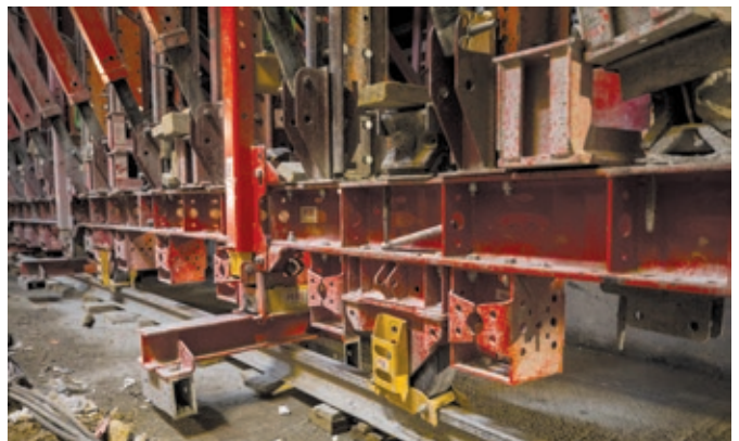
Pomicanje kretke – kotači s vodilicama za željezničke šine
