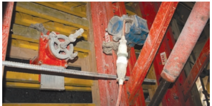
Priključci pumpe za betoniranje i oplatni vibratori
