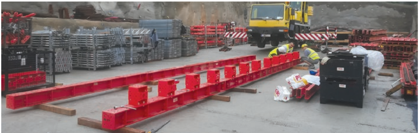
Početak montaže VARIOKIT nosivog okvira kretke na gornjem platou gradilišta
