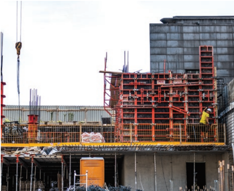
PROKIT rešetke za zaštitu od pada. SKYDECK sistem i PEP podupirači kao rješenje za izvedbu stropova.
