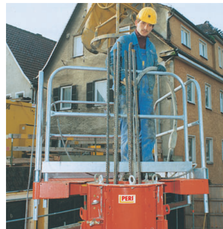
Sigurni radovi na podestu za betoniranje na svakoj visini.
