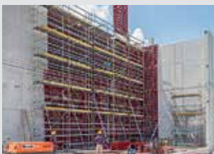
Građevinske radne skele
