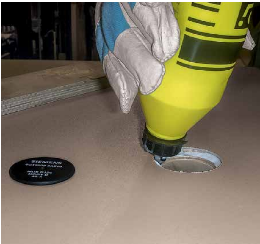
Ugradnja RFID čipova u PERI Pave podložnu ploču moguća je i naknadno pomoću seta za popravak.
