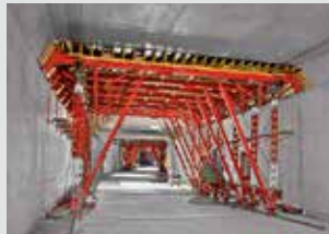
Oplaste za tunele
