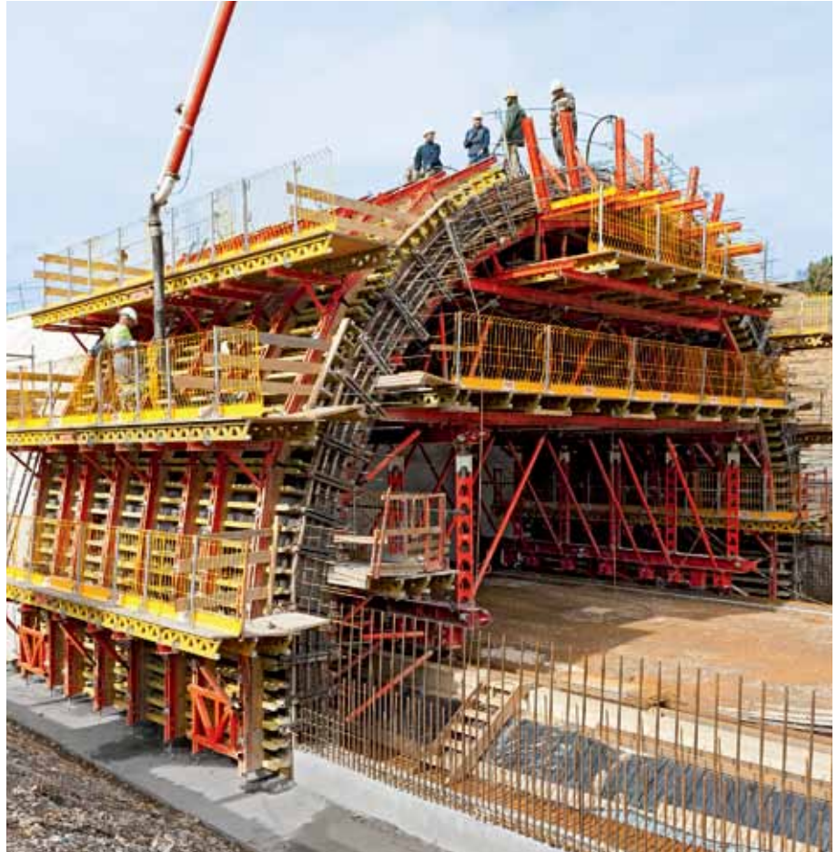
PROKIT EP 110 nudi zaštitu na svim slobodnim rubovima radnih podesta ove oplata tunela.
