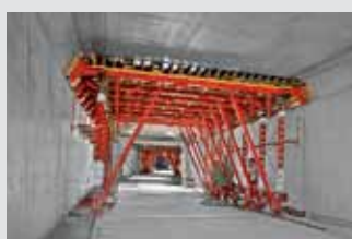
Oplaste za tunele
