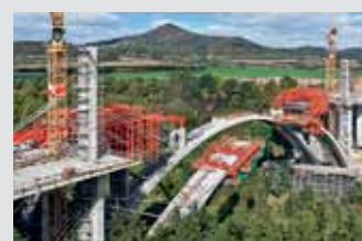
Oplaste za mostove
