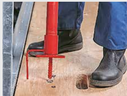
Čeoni stup FBP za prihvat gradilišnih daski ograde uvrće se u višenamjensko pričvršćivanje (DW 15).
