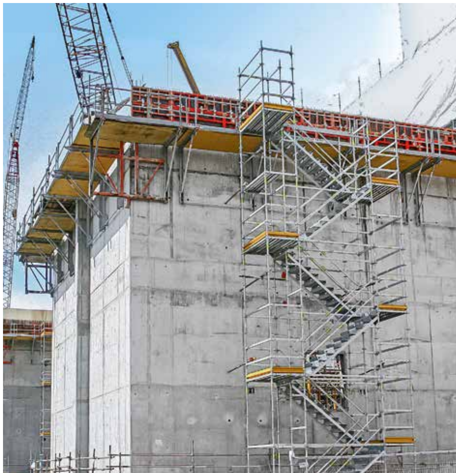
Sklopivi kutni podest za vanjske kutove objekta može se primjenjivati slijeva i zdesna. Time se smanjuju količine zaliha i pojednostavljuje logistika.
