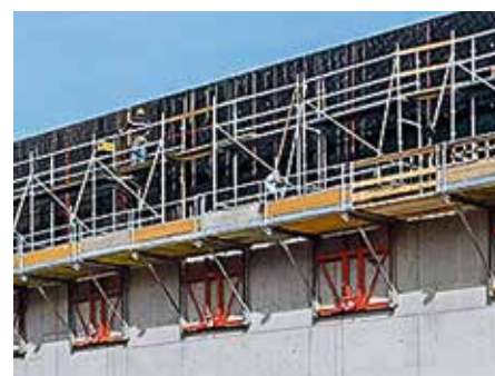
Sklopivi kutni podest u primjeni na ravnom zidu s podignutom armaturnom skelom PERI UP.
